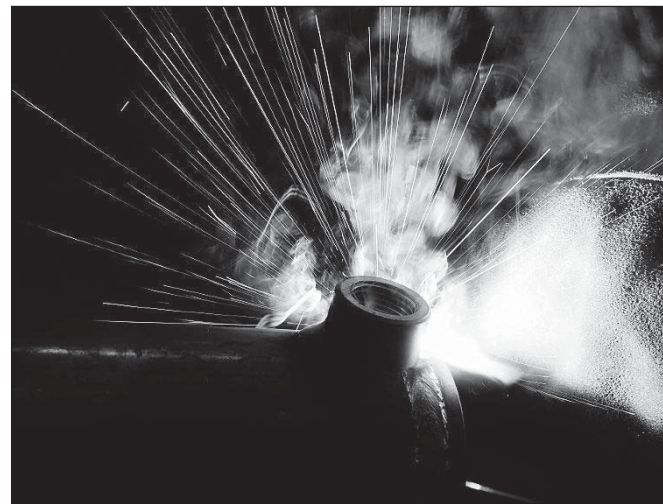
Met het lasapparaat worden toebehoren op de cilinder 'geplakt'
